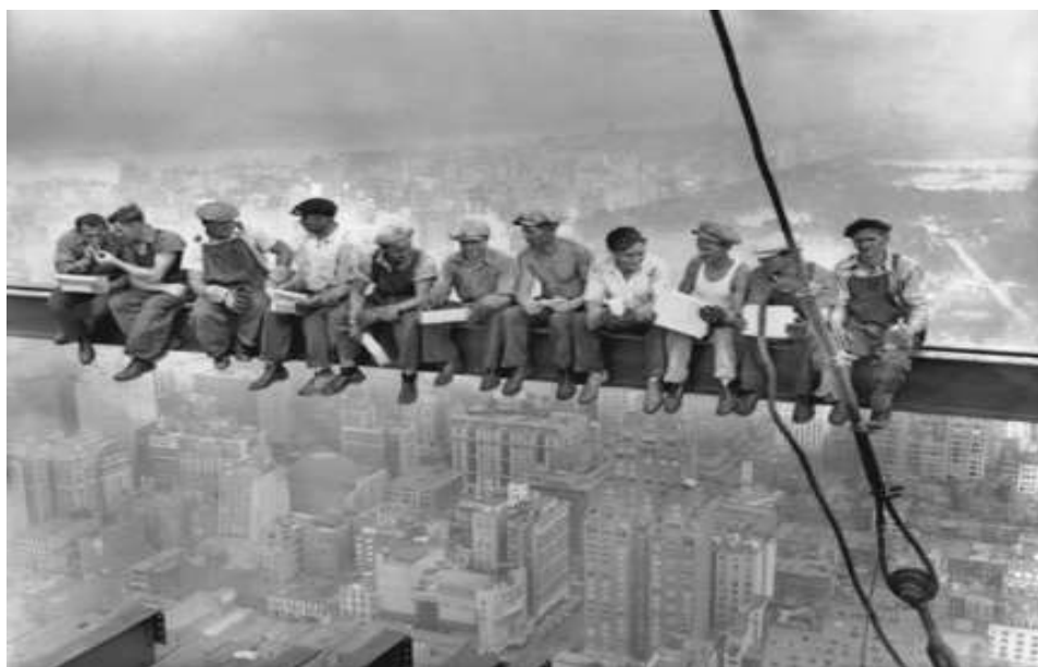
Figura 9. Imagem de operários almoçando em vigas de aço na construção do edifício Rockefeller Center. Fonte: http://www.museudeimagens.com.br/rockefeller-center/ ; acesso em 19/04/2016.
